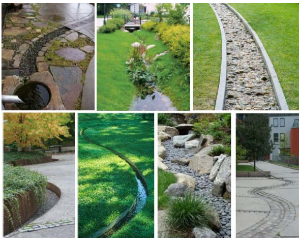
Kuva 5.1. Hulevesien johtaminen rakennetussa uomassa/kourussa.
